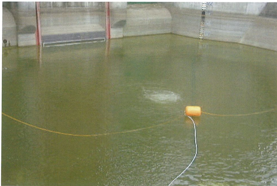
撮影：平成 12 年 7 月 20 日 pm 1:00 A 地点 運転開始後 20 時間後 アオコ層及び臭気消滅 A 地点でも全く臭いがしなくなった。 表層水温：21℃ エアーリフター設置：水深約 6m
